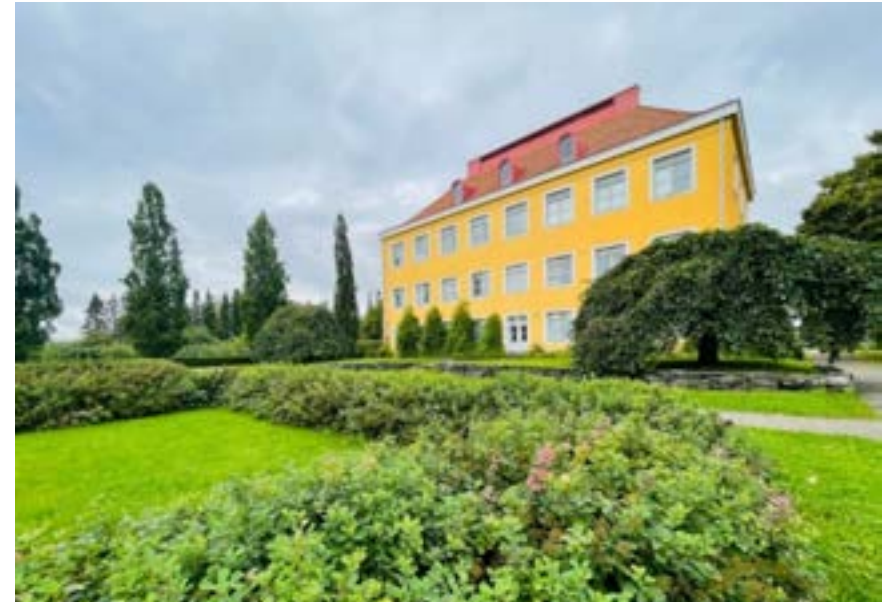
Kuva 36. Opisto -rakennuksen barokkipuiston puoleinen julkisivu
