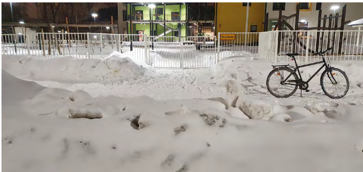
Päiväkodin pelastustie lumivallin takana. Pelastustien liittymän avaus ajoradalle ja jalkakäytävän talvihoito kuuluvat kiinteistölle.
