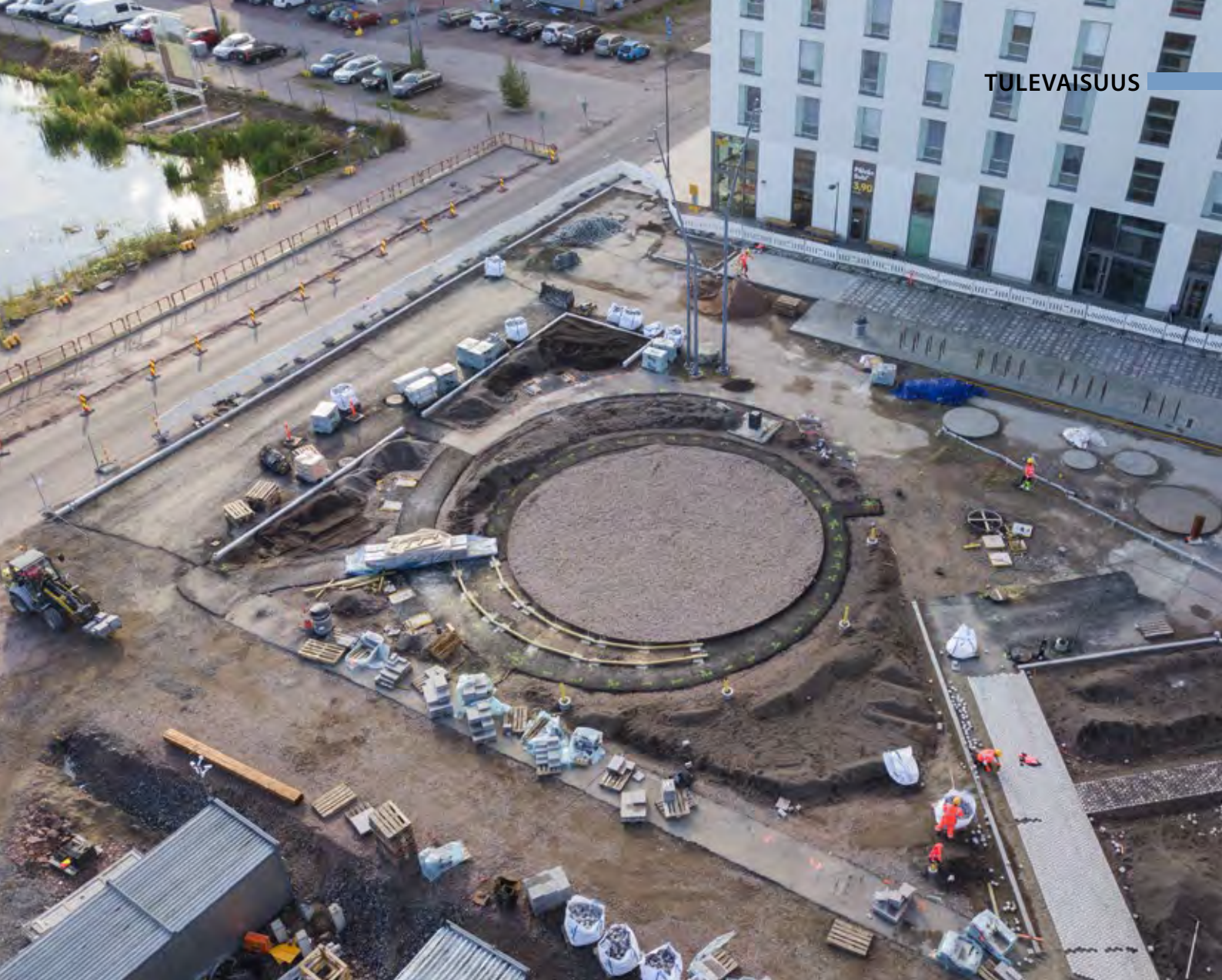
Päästöttömyyden työmaan periaatteilla toteutetun Lukutorin linjat alkavat hahmottua. Kuva: Suvi Suovaara
