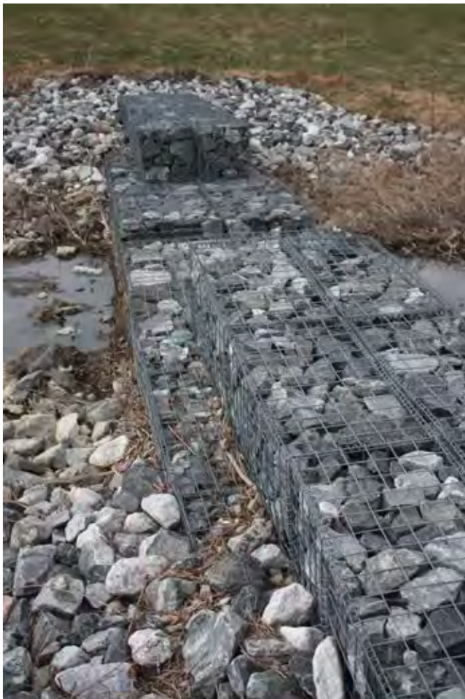
Hulevesiuoman poikki on rakennettu kivilta, joka hidastaa vir- tausta ja suodattaa kiintoainesta.
