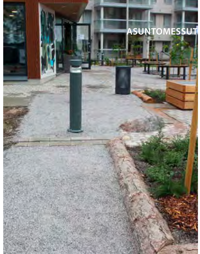
Eri suunnitelmien yhteensopimattomuudesta tai mittavirheestä johtuen pollarivalaisin on keskellä käytävää.
