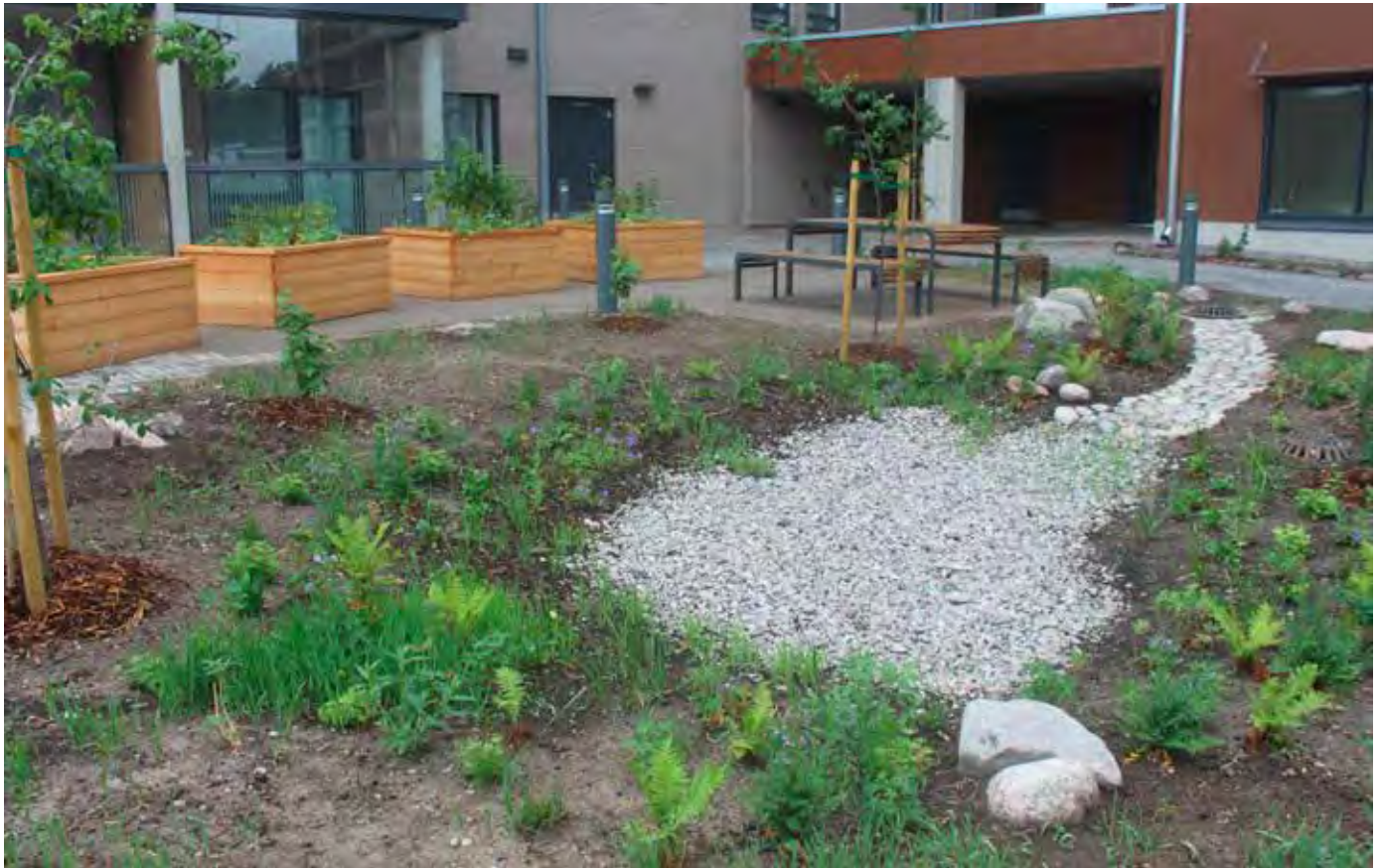
Osa kattovesistä johdetaan kasvillisuusalueelle painanteeseen.
