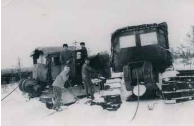
J-Trading osti 1986 sisarusten isän, Kurt Juslinin maanrakennus-yrityksen liiketoiminnan. Kuvassa Brita ja Kurt Juslin vierailevat ojitustyömaalla 1950-luvun lopulla.
