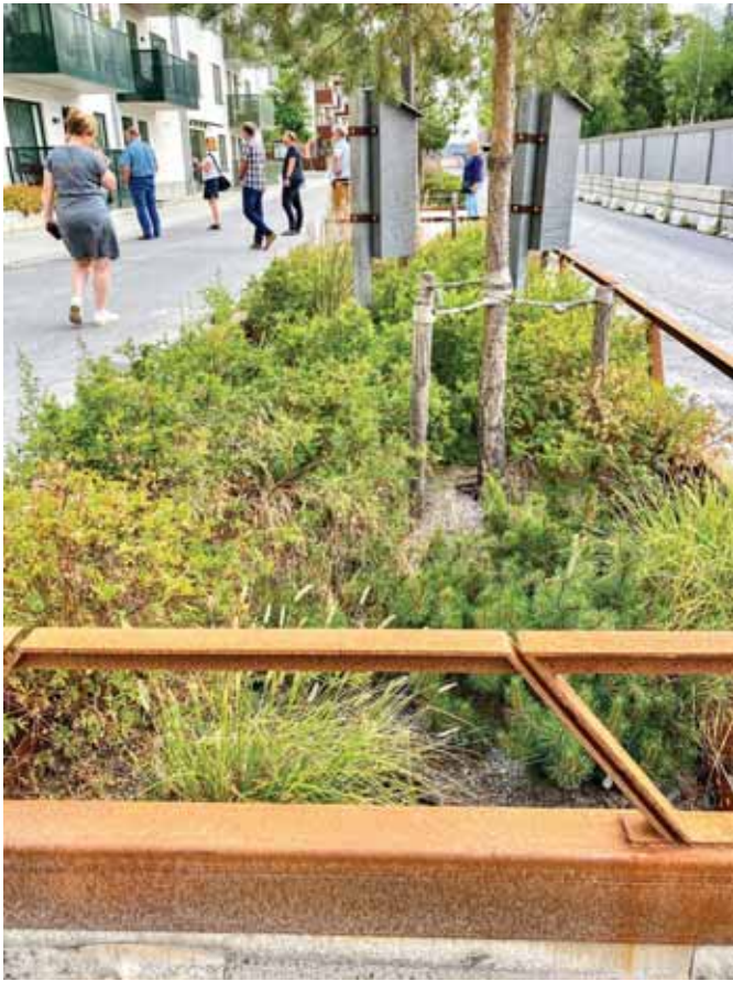
Katuvesien imeytysaltaita kutsutaan Ruotsissa sadetarhoiksi. Niissä kasvaa usein erilaisia pensaita ja heiniä, jotka ovat kunnossapidon kannalta perennoja helpompi ratkaisu. Kuva Täby Parkista.
