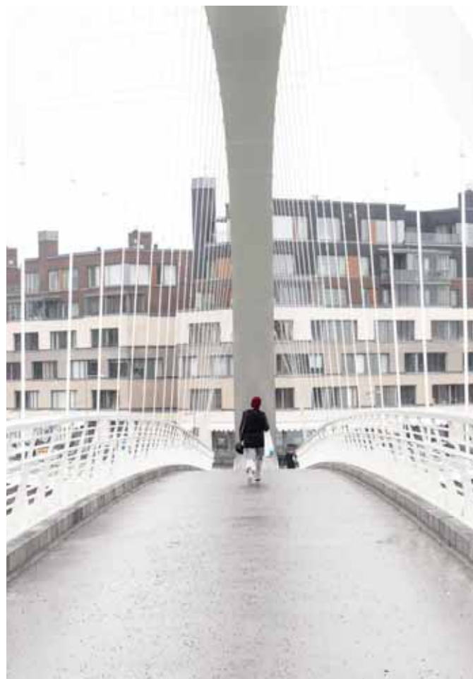
Kevyenliikenteen sillalta avautuvia maisemia tiiviisti rakennettuun kaupunkiympäristöön. Toisessa suunnassa maisemat jatkuvat ulkoilualueena.
