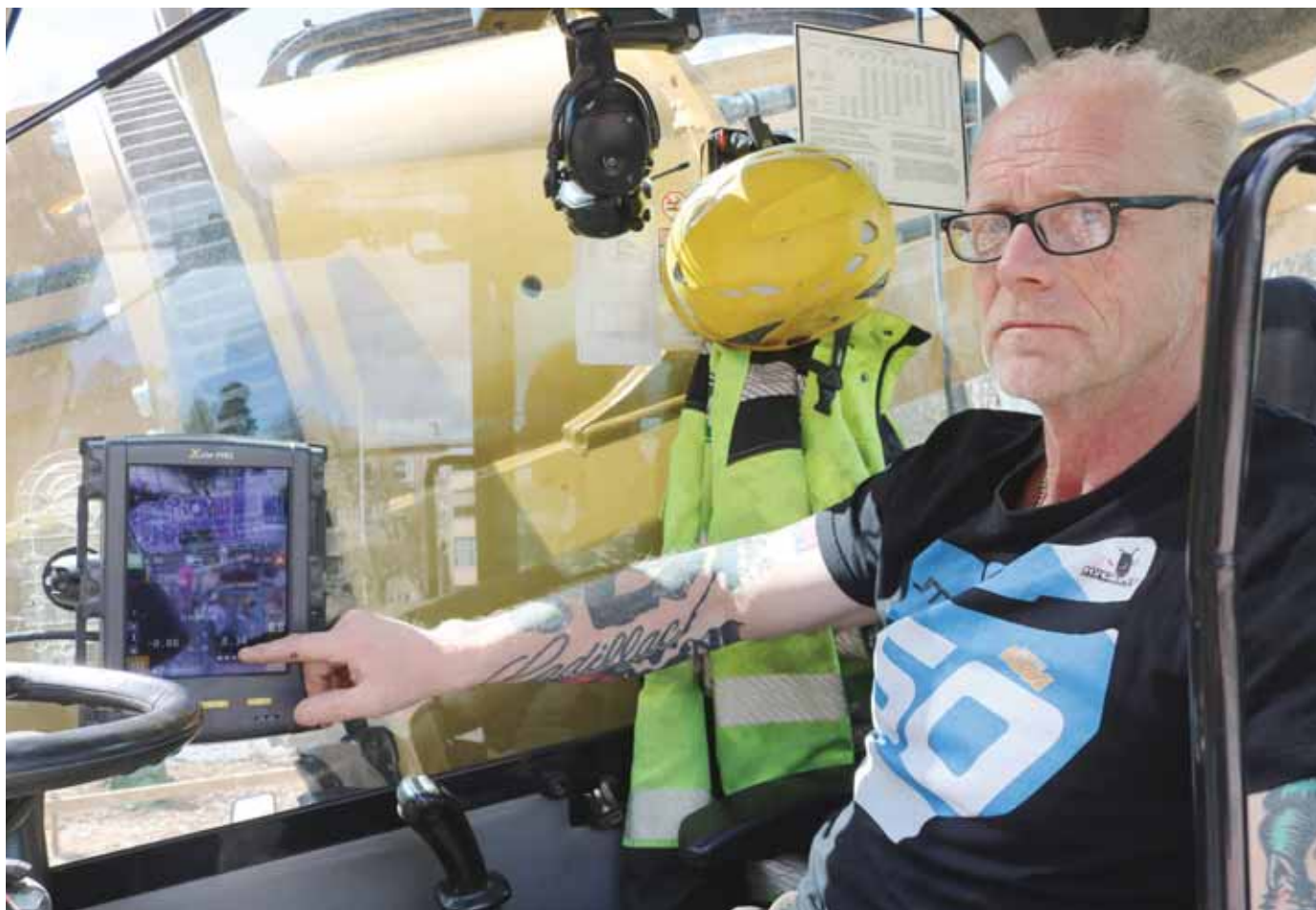
Kaivinkoneessa työskennellessä esimerkiksi kaivuusyvyyskiä ja toteumamittauksia hallitaan digitaalisesti. Näkymää esittelee Tieluiskan työntekijä Marko Pyykkö.
