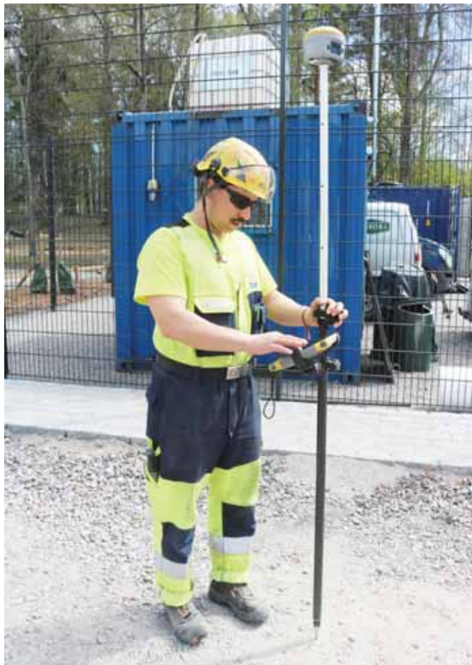
Mittauslaitteella voidaan tarkistaa merkkauseineiston avulla, että maakerrokset asettuvat oikealle tasolle. Kuvassa laitetta käyttää Staran työntekijä Olli Juntunen.
