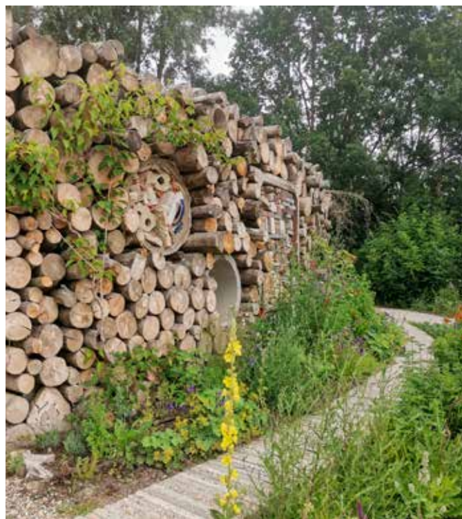
Utopia Island -alueelle oli rakennettu lahopuumuuri puiden run- koja, betonirenkaita ja tiiliä hyödyntäen. Tapahtuman jälkeen ra- kennelmasta tulee luonnon valtaama ”ekokatedraali”, joka muut- taa muotoaan luonnon ehdoilla.
