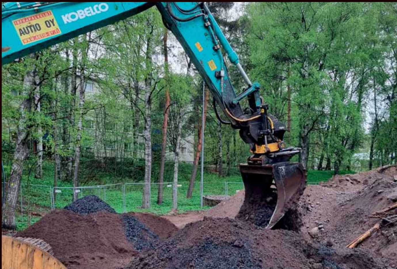
Herttoniemen Oravapuistossa sekoitettiin biohiili kasvualustaan paikan päällä. Riittävä biohiilen kosteus takasi pölyämättömän toimenpiteen.
