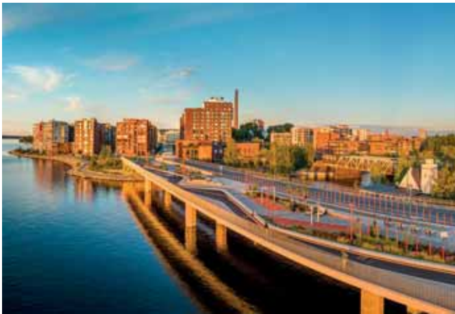
Silta sai uuden elämän, kun se muutettiin puistosillaksi. Sillan purkamisen ja sen alla sijaitsevien kunnallisteknisten runkolinjojen siirto olisi ollut kallista ja epäekologista. Kuva: Marko Kallio, Skyfox
