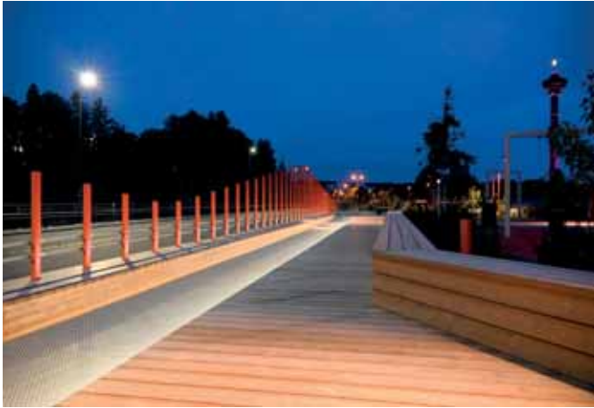
Silta iltavalaistuksessa. Siltojen välisen tilan päälle muodostuu elämyksellinen kävelyreitti, jonka kulkupinnan teräsritilän läpi näkyvät Tammerkosken veden pyörteet.
