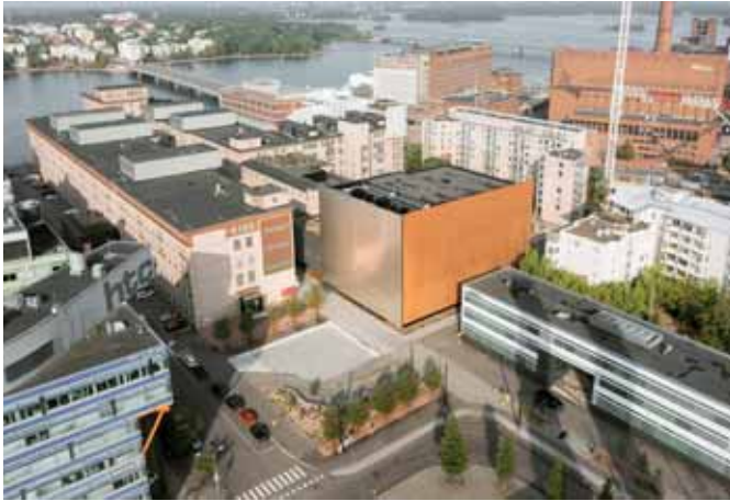
Kaapeliaukio on uuden Tanstin talon ja historiallisen Kaapelitehdas sisäntulo- ja tapahtuma-aukio. Kuva: Hannu Rytty
