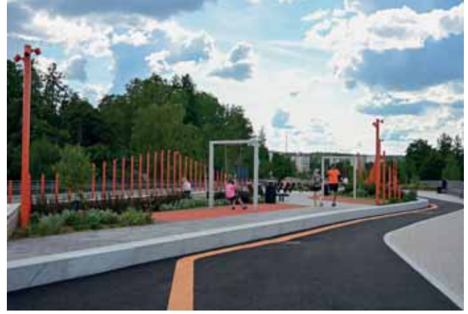
Sillan pituussuuntainen aaltoileva luonnonkivimuuri jakaa sillan kahteen osaan: liikkumisen vyöhykkeeseen ja muurilla korotettuun oleskelun alueeseen.
